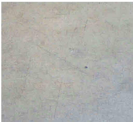
← Bild 1: Haarrisse in einem Zementestrich
